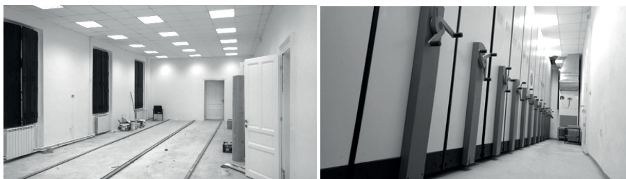
Slike 13 i 14. Rekonstrukcijski radovi u depou 1; Obnovljeni depo 1
