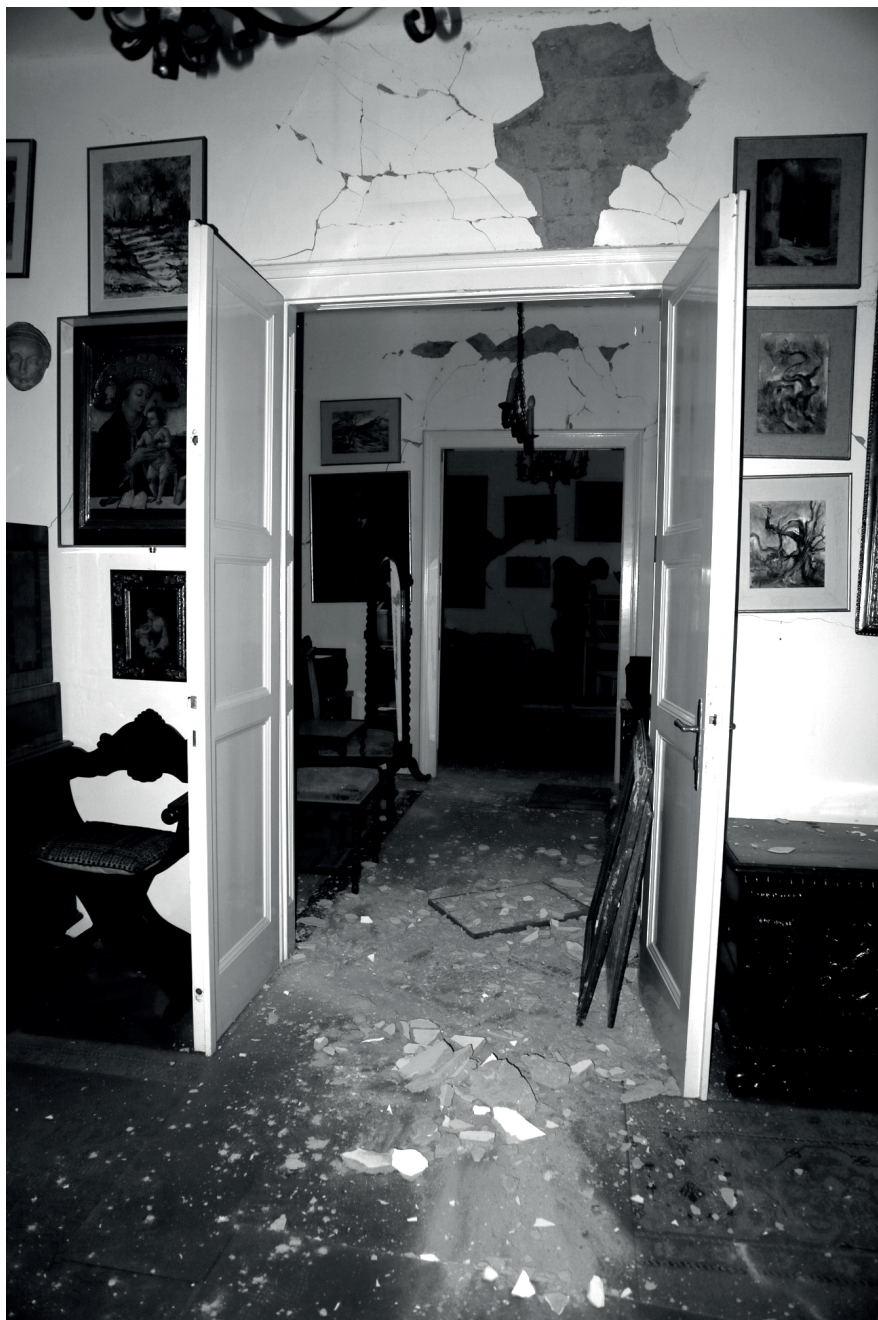
Slika 4. Dijelovi žbuke i cigli na podu stana
