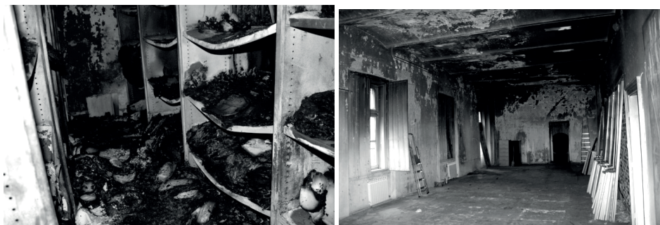
Slike 7 i 8. Depo 1 neposredno nakon požara; Depo 1, soba 1 pripremljena za restauraciju
