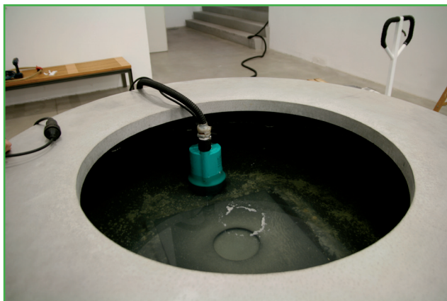
Ispumpavanje vode iz bunara
