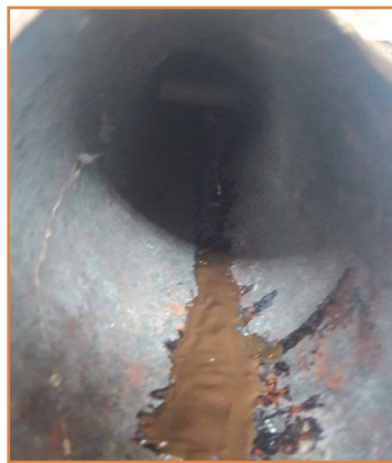
a, b, c Fiksiranje i zapunjavanje pukotina
